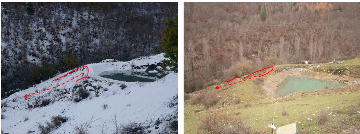
Figure 17: Glissement de terrain sur le parement aval d'une retenue d'eau (Barret de Lioure)
