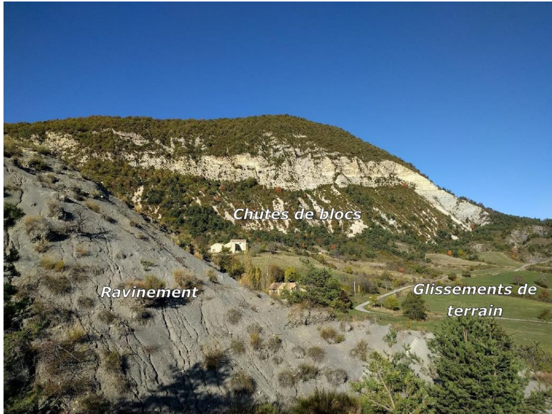
Figure 6: Panorama de la Tuilière à Laborel (source : Géolithe)
